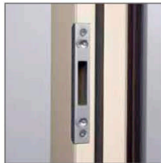
Schräg verschraubtes SCHLIESSSTÜCK für die Aufnahme der beiden Schwenkriegel
